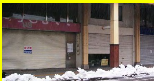
閉まっているシャッターも目立ちます
