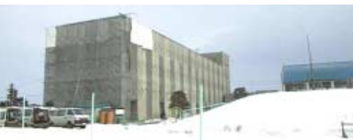
雨漏り等の改修がすすむ富岡小校舎
