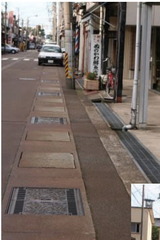
上、仲町6丁目の側溝と流雪溝 右、今井染物店裏の用水と流雪溝
