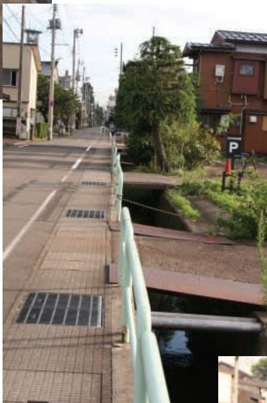
上、仲町6丁目の側溝と流雪溝 右、今井染物店裏の用水と流雪溝
