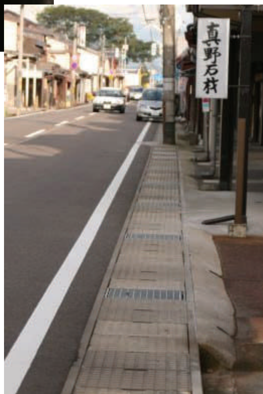
下、東本町2丁目の改良された側溝兼流雪溝
