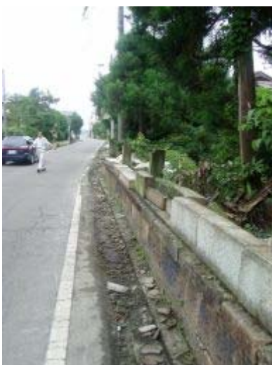
大谷石の塀はどこでも倒壊しているのが特徴です(頸城区にて)
