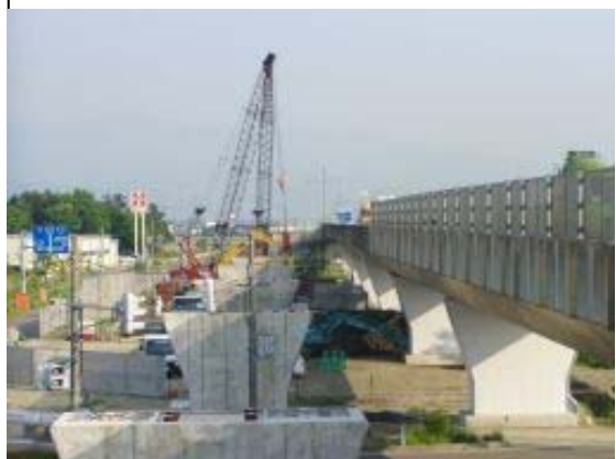
架橋工事が進む上新バイパス四ヶ所IC
