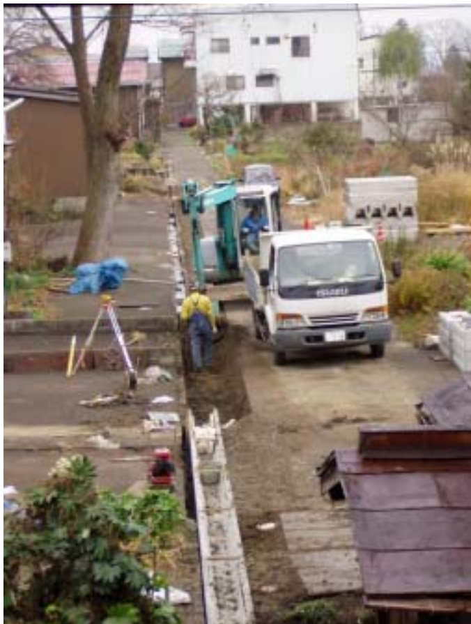
工事が始まった東本町5丁目南裏の排水路
